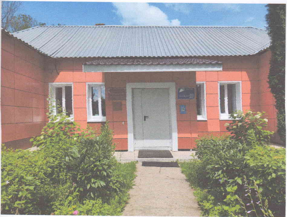
Фото № 1 – Входная площадка
