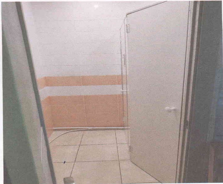
Фото № 1- Санитарно-гигиеническое помещение
