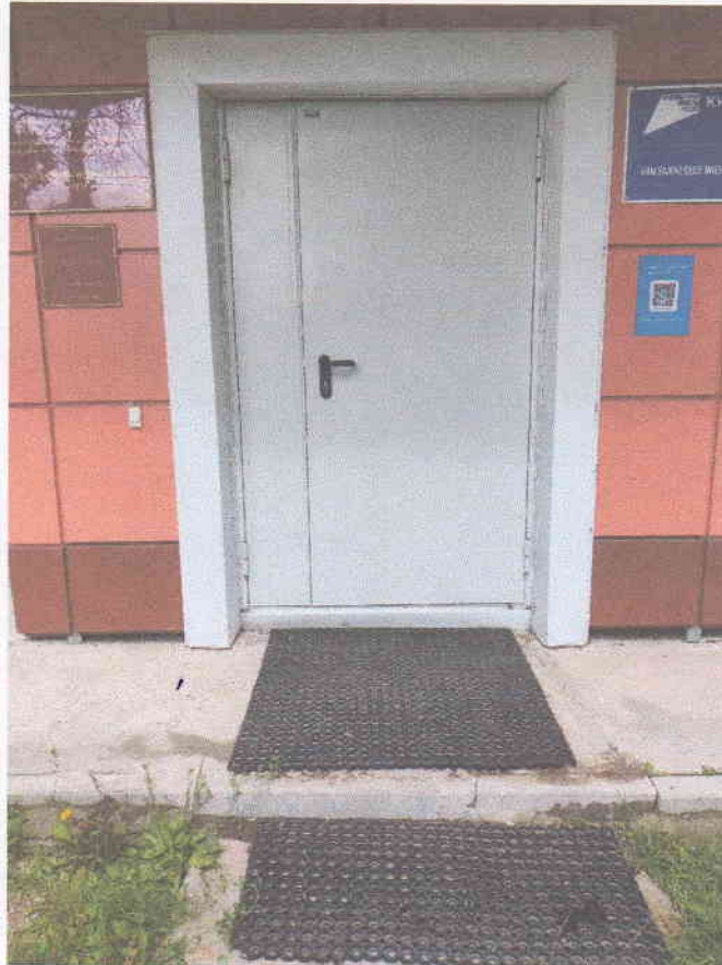
Фото № 3- Входная дверь
