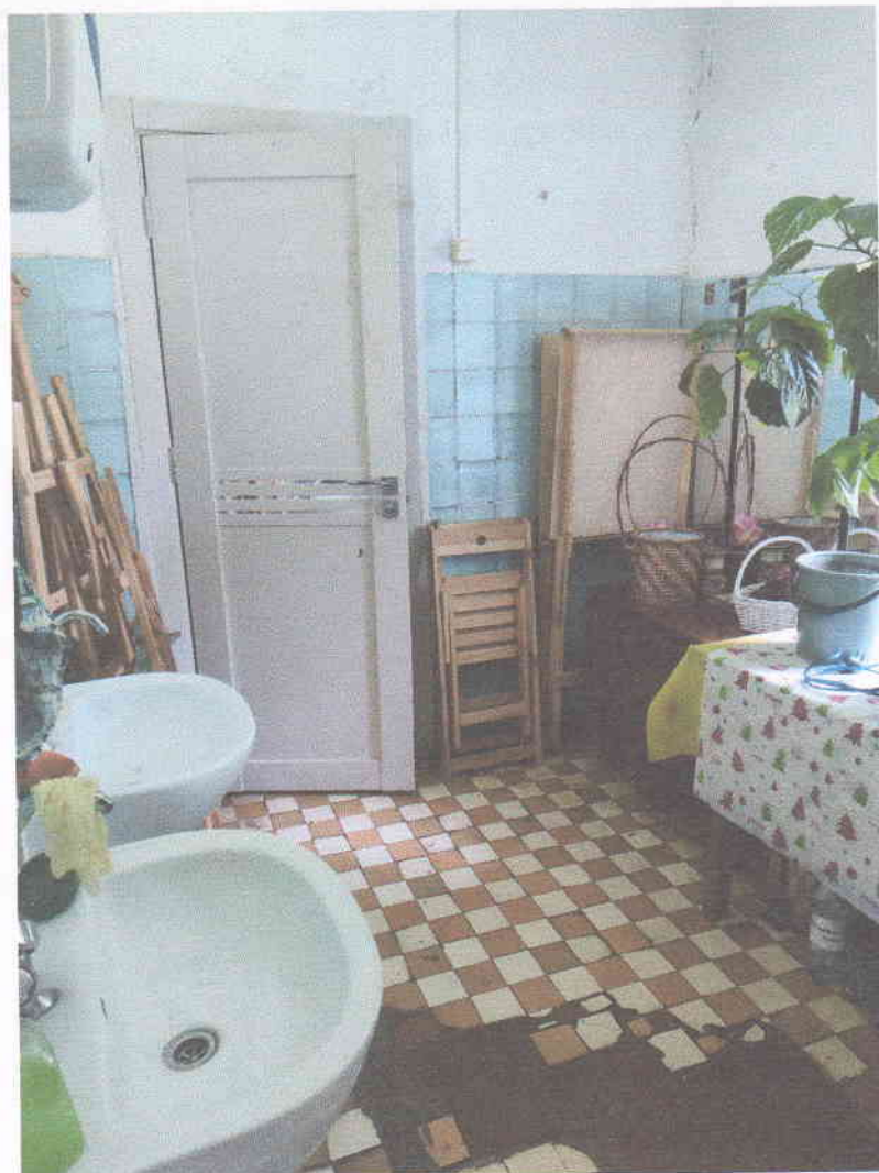
Фото № 2 – Санитарно-гигиеническое помещение
